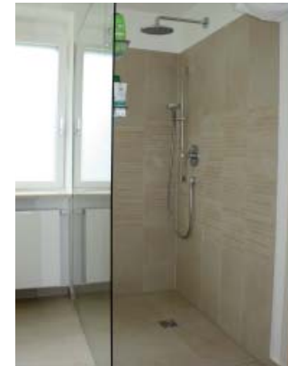
Bad OG ebenengleiche Dusche
