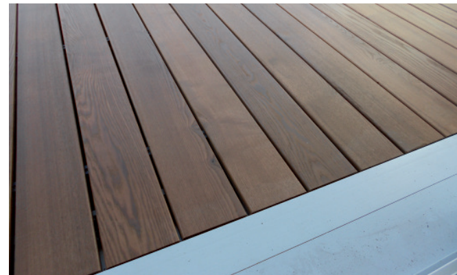
ebenengleicher Zugang zur Terrasse
