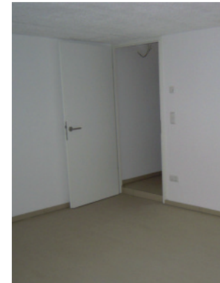
Absenken der Bodenplatte KG
